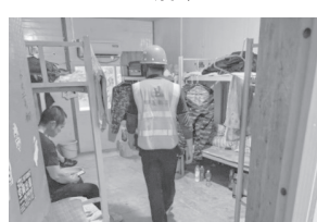
禾元生物项目生活区专项检查
