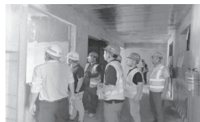
二航局各项目开展安全生 产月专项检查
