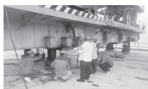
各单位对安全作业条件情况进行确认，逐项落实施工安全防护措施
