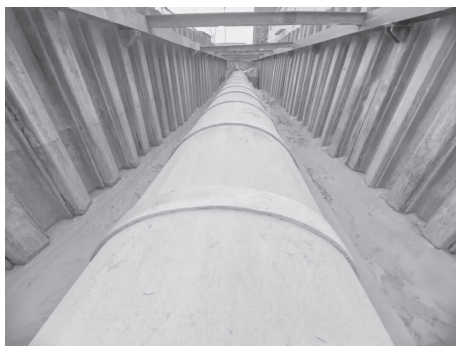
△建设中的蔡甸管网改造工程
