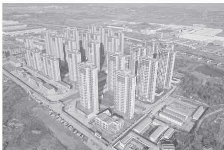
△建设中的麦山五期项目
