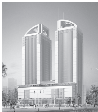
△湖北省住建厅合同能源托管服务项目
