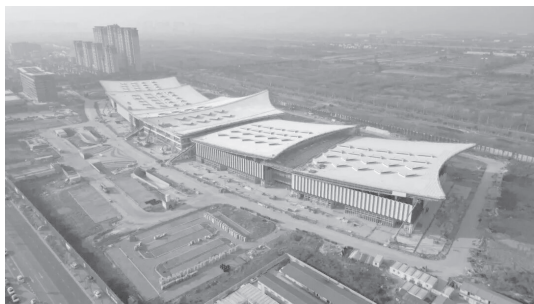
△建设中的荆州江汉平原产业交流中心项目
