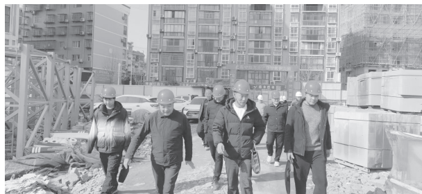
检查组检查现场情况
