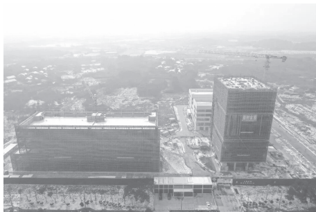
△建设中的武汉航空新材料产业园（一期）项目
