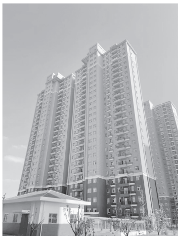
△武汉彭山街产城融合示范新区一期项目8号楼
