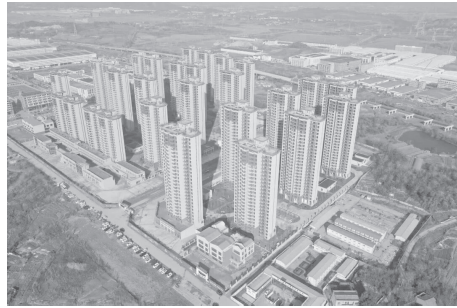
△建设中的麦山五期项目
