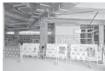
塔吊基础标准化处理
