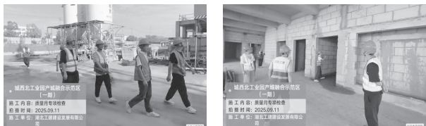
大冶湖高新区城西北产城融合示范区项目开展现场质量检查
