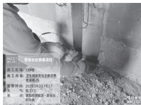
联投长虹印象砌筑工程、卫生间反坎交界处涂刷JS等施工工艺
